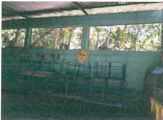
Foto 3: Cambio de ventanas a ventanas de PVC.
