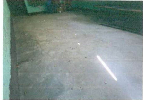
Foto 2: Cambio de piso de cemento a piso ceramico o granito de 2 aulas.
