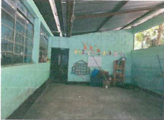
Foto 1: Cambio de cubierta de lamina calibre 26 troquelad. Caída de agua pluviales y canales de 3 aulas.
